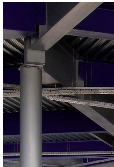
Source Efectis France – Droits réservés Parking aérien en acier dans le sud de la France traitement intumescent sur bracons
