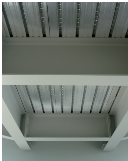
Source PPG France Peinture intumescente sur charpente intérieure
