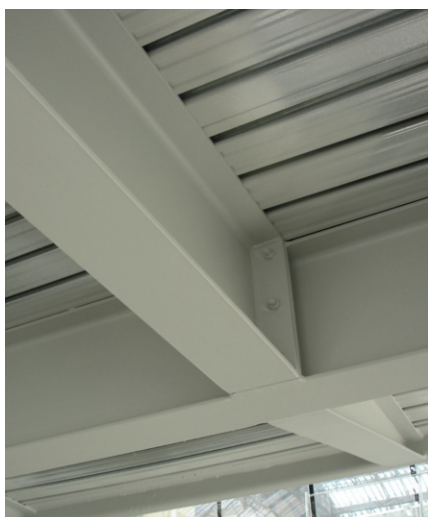
Source PPG France - Peinture intumescente sur charpente intérieure
