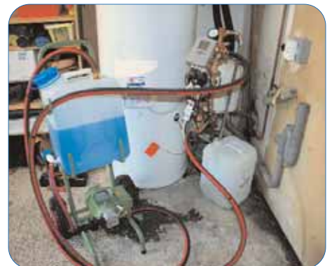
Remplissage et rinçage du circuit solaire
