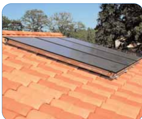
Capteurs posés sur tuiles
