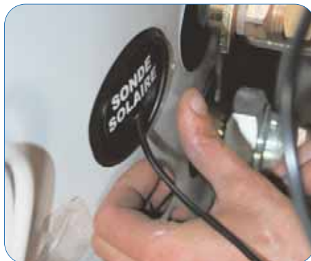
Mise en place des sondes
