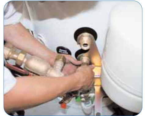
Montage de l'ensemble hydraulique
