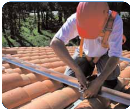
Montage des rails
