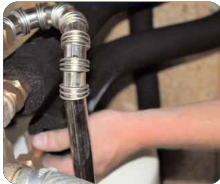
Raccordement des tubes des capteurs
