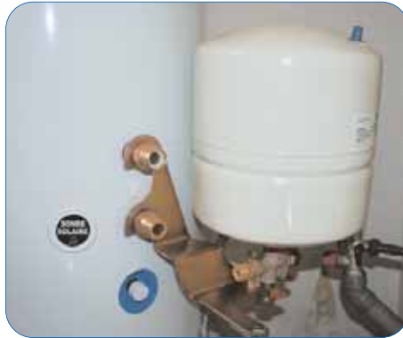
Mise en place du vase d'expansion et son support sur les adaptateurs
