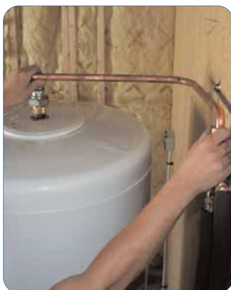
Raccordement eau chaude avec mitigeur
