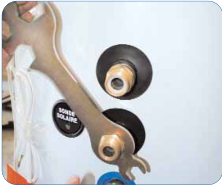
Mise en place des adaptateurs
