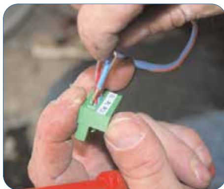
Raccordement de la sonde de température capteur
