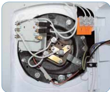
Raccordement appoint électrique. Câblage en 230 V mono
