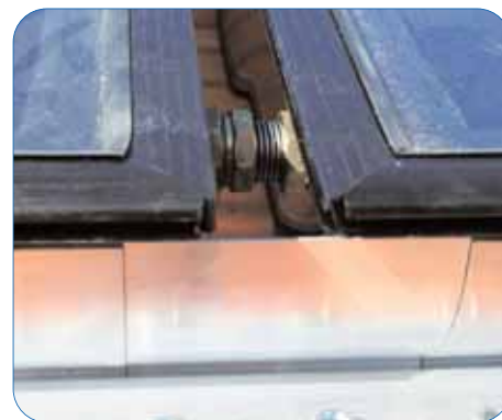
Vissage des compensateurs
