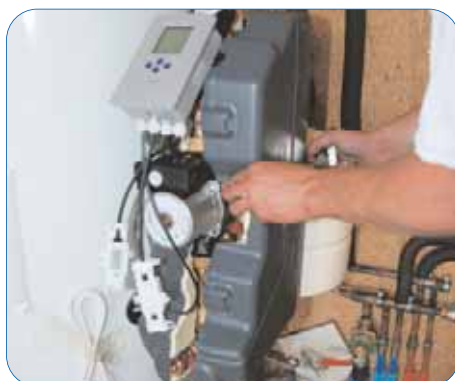
Mise en place de l'isolation
