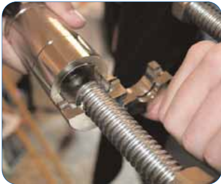
Raccordement des tubes des capteurs
