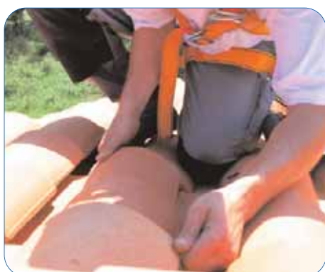
Recouvrement avec les tuiles
