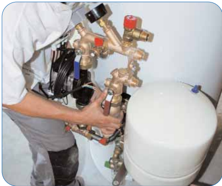
Montage de l'ensemble hydraulique
