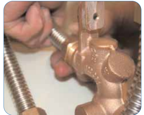
Raccordement des tubes des capteurs
