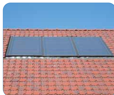
Capteurs intégrés aux tuiles
