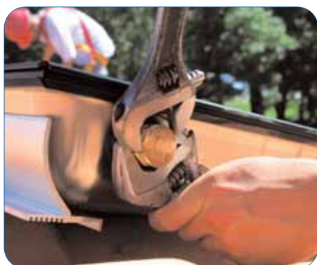
Mise en place du bouchon
