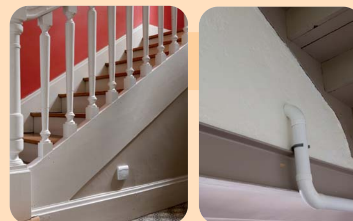
exemple de passages sous un escalier
